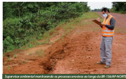
Supervisor ambiental monitorando os processos erosivos ao longo da BR-156/AP-NORTE.
