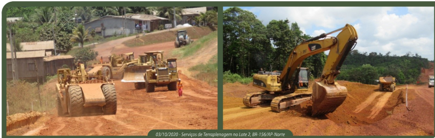
03/10/2020 - Serviços de Terraplenagem no Lote 2, BR-156/AP-Norte
